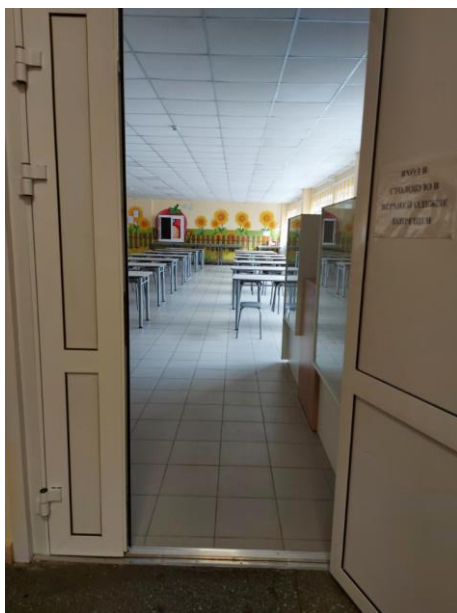
Зона целевого назначения здания. Столовая (Фото 19)
