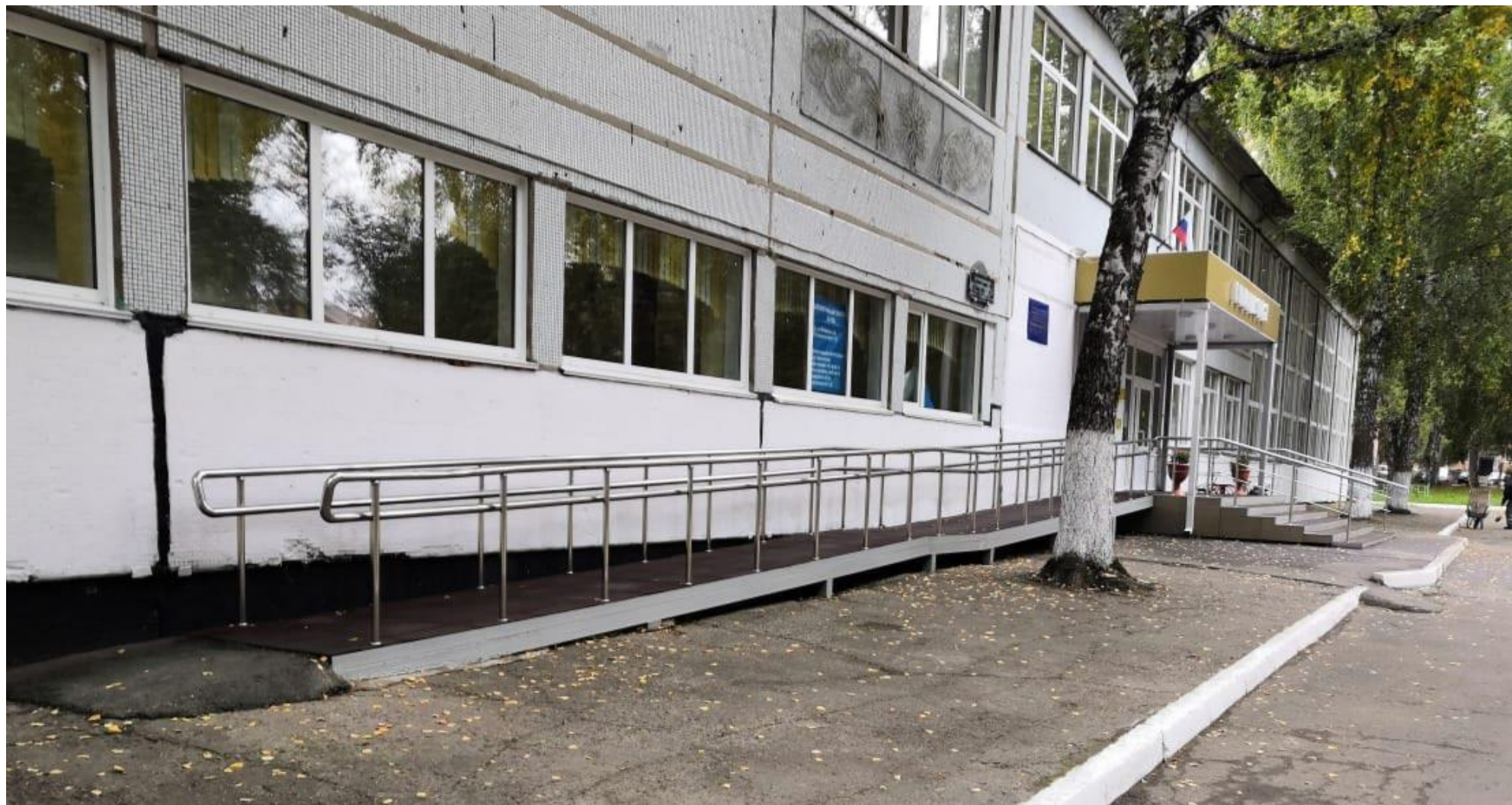
Территория, прилегающая к зданию. Пандус (Фото 7).
